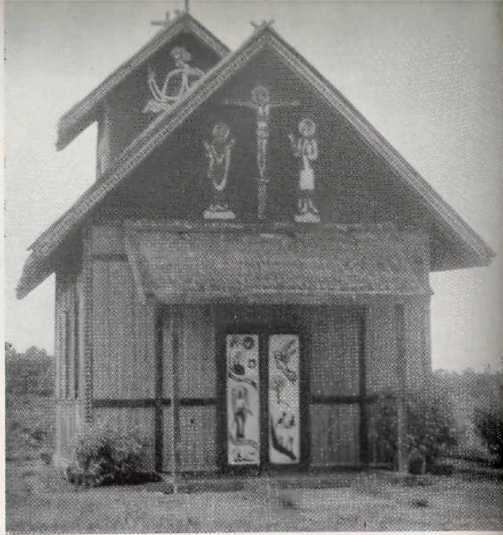
Kapel van Voorlopers-school. Exterieur
