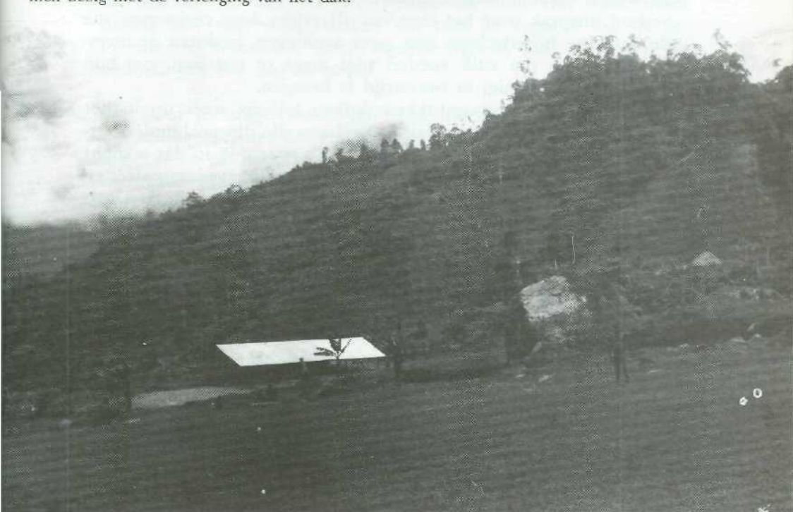
Het nieuwe dak van de kerk in Landikma is klaar! Alle mensen kunnen nu 's zondags binnen zitten; op de voorgrond een gedeelte van de strip.
