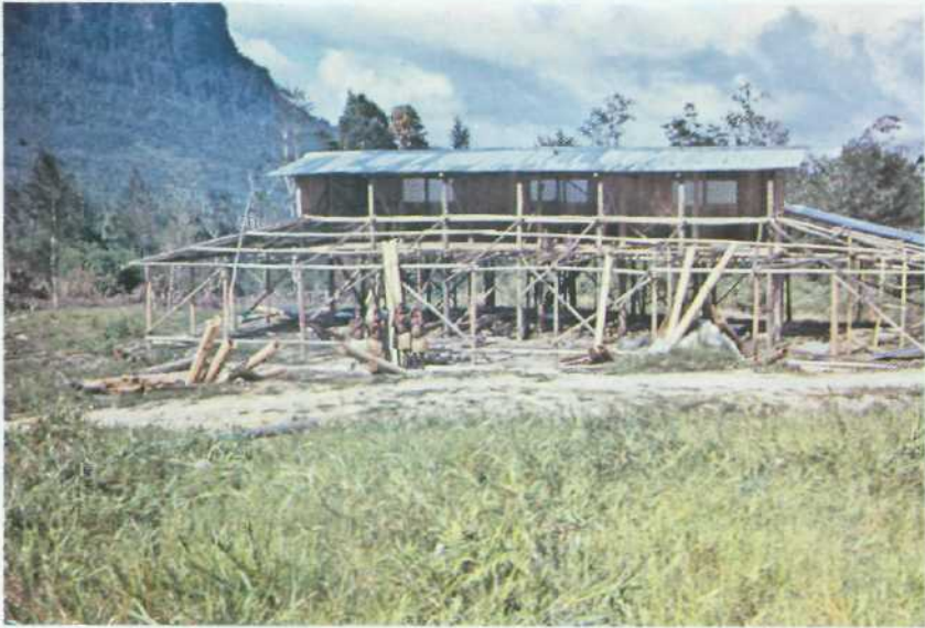
De school in Abenago in aanbouw; de wanden werden door de Jali's bekleed met boomschors, dat vaak door de vrouwen gebracht werd.
