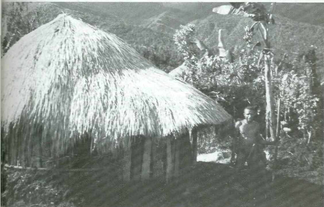
De hut is afgebouwd; duidelijk is het voorportaalte te zien.
