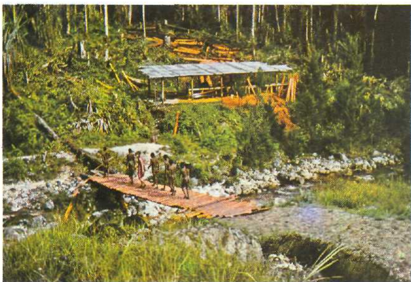
Een kijkje op het dak, waaronder de zaagmachine staat opgesteld; op de voorgrond de Bion-rivier en de brug.
