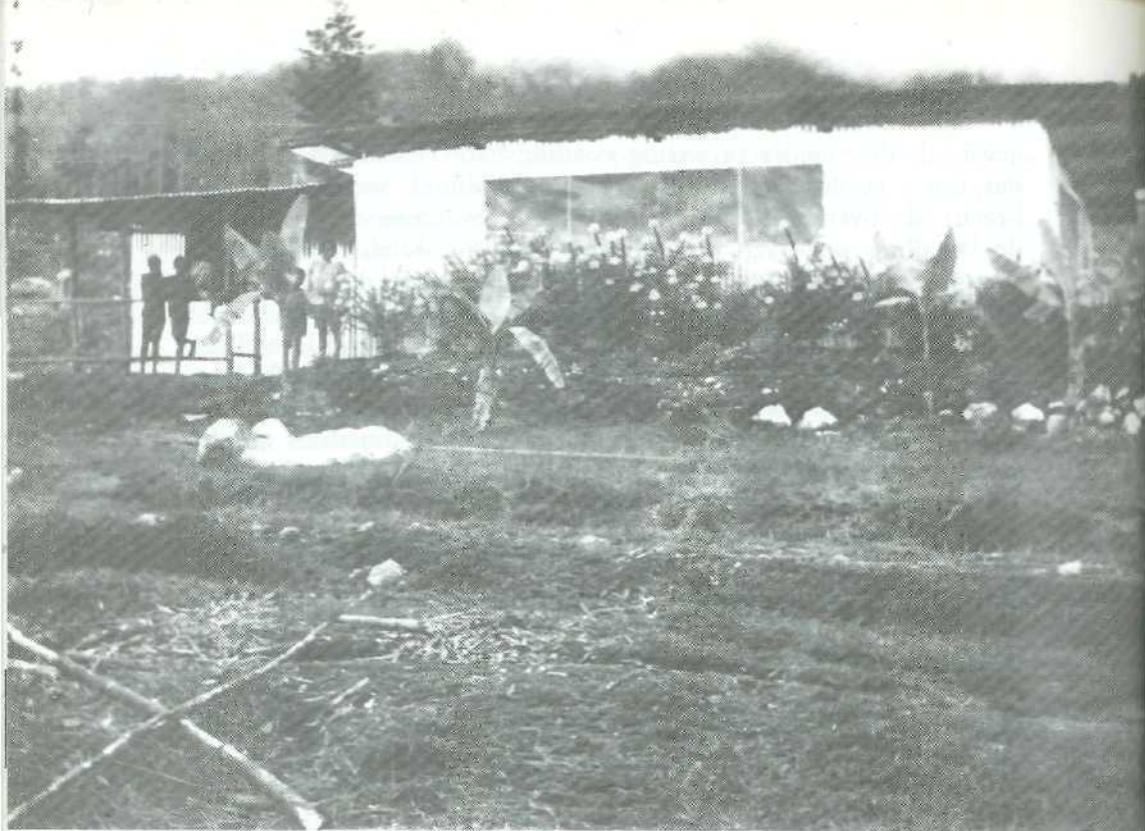
De bijna voltooide polikliniek in Abenago; voor de wachtruimte staat o.m. de plaatselijke verpleger; het grote raam in het midden verlicht overdag de behandelkamer en de ruimte, waar de verpleger werkt.
