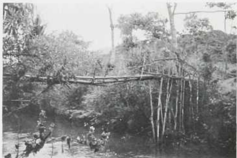
Afb. 25. Liggerbrug van meer ingewikkelde structuur, voorkomende in de vlakte ten Oosten van het Paniai-meer. (Zie dl. I, p. 340 e.v.)
