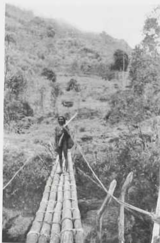
Afb. 23. Eenvoudige liggerbrug, van enige dunne boomstammen vervaardigd, over een smal ravijn.
