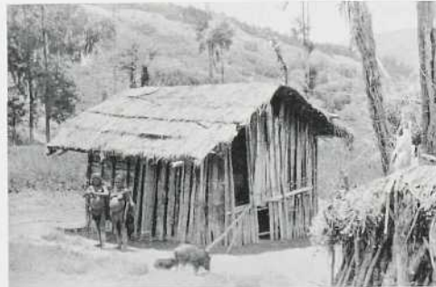
Afb. 89. Zelfde huis als op afb. 87, schuin van voren gezien. Schuine stok als oploop bij de ingang; onder het huis een opening voor de varkens. De rotandraad loopt van het dak naar de tuinen. (Zie dl II, p. 622)
