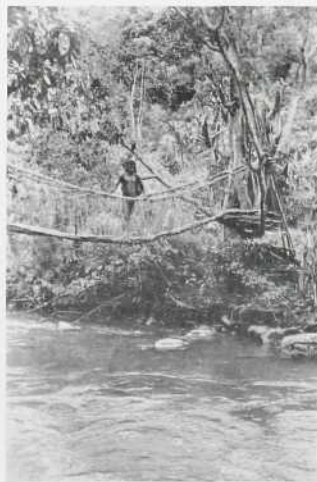
Afb. 26. Kleine hangbrug aan twee rotan- kabels, die bevestigd zijn aan bomen.
