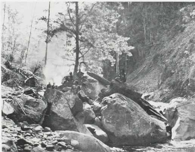
Afb. 16. Ravijn met afgestorte wanden op de linkeroever van de Nögölo.
