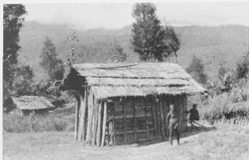
Afb. 87. Als afb. 84 en 86. Duidelijk is de antenne op het dak zichtbaar.
