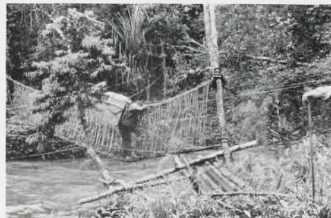
Afb. 24. Hangbrug aan één kabel over de \approx 15 m brede Araboe bij Ibowasiga. (Zie dl. I, p. 346)
