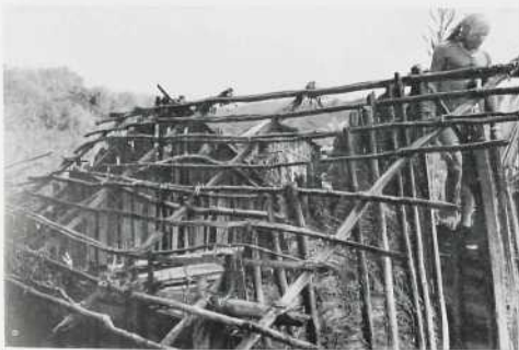
Afb. 93. Als afb. 92. De wanden worden met gras opgevuld
