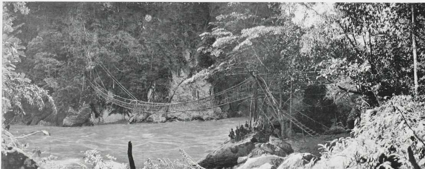
Afb. 19. De grote rotanbrug ( pisi gawa ) over de Nögölö bij Tombe, van dichtbij gezien. De kabels zijn bevestigd aan kunstmatige pijlers. (Zie dl. I, p. 341 e.v.)
