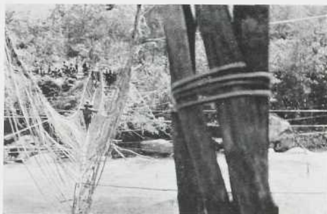
Afb. 22. Grote rotan hangbrug aan twee kabels over een grote rivier. (Zie dl. I, p. 341 e.v.)
