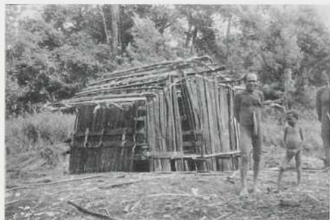
Afb. 95. Woning der Moni, practisch gereed: Op de achtergrond zijn de boombastplaten voor de dakbedekking zichtbaar
