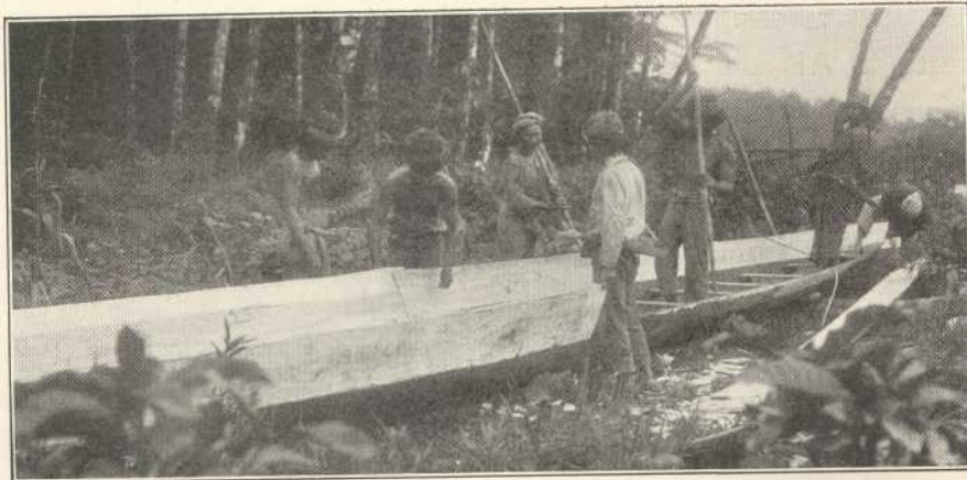
HET PLAATSEN VAN DE BOORDEN OP EEN PRAUW.
