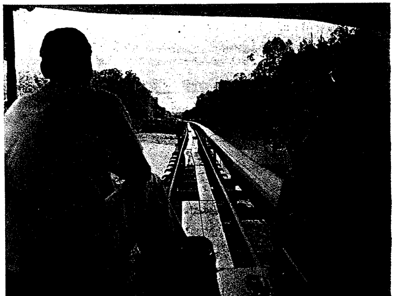
Pijpleiding op jukkenbrug.
